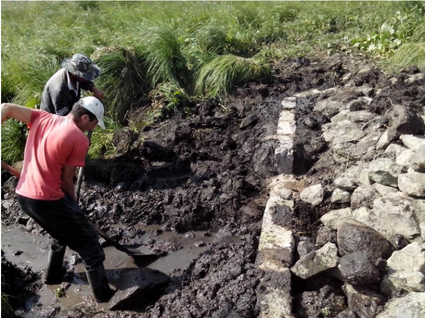
Նկար 4. Աղբյուրի ակունքի բացման աշխատանքներ
