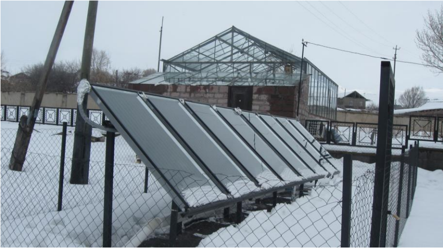
Նկար 3. Բասենի մանկապարտեզի արևային ջերմային կոլեկտորները և փորձացուցադրական ջերմոցը
