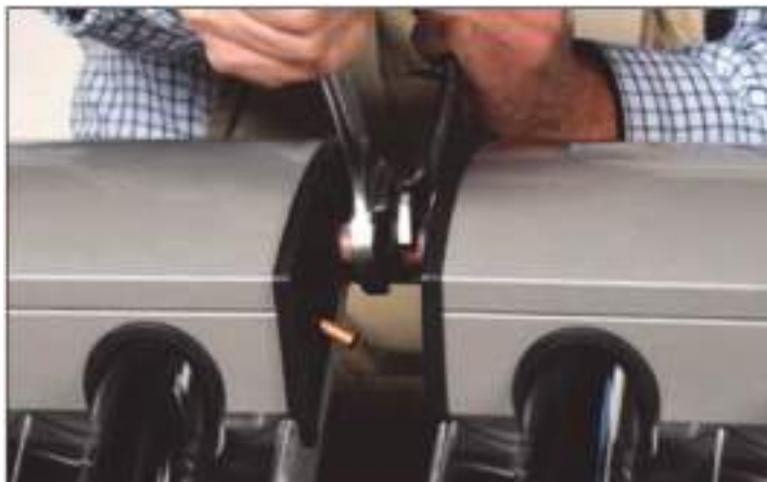
Նկ. 3.13.6. Երկու մանեկային դարձակների միջոցով կոլեկտորների հաջորդական միացում
