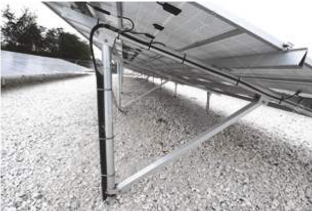
Նկ. 7.3.4. Մալուխների ճիշտ կատարված մոնտաժի օրինակներ
