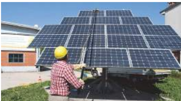
Նկ. 7.4.1. Արևային ֆոտովոլտային մոդուլների մակերեսի մաքրումը խոզանակով և ջրով
