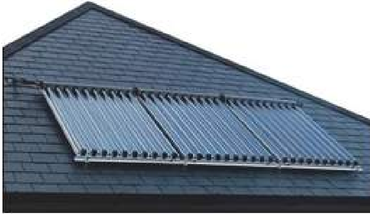
Նկ. 3.13.4. Հաջորդաբար միացված արևային կոլեկտորներ
