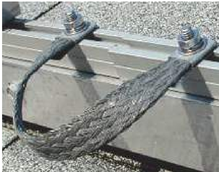
Նկ. 6.6.5. Ռելսերի հարևան կտորների կցումը միմյանց հաղորդչով հողանցումն ապահովելու նպատակով
