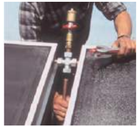
Նկ. 3.6.4. Կոլեկտորների խողովակների մոնտաժում (ձախ), օդանցքի տեղադրում (աջ)
