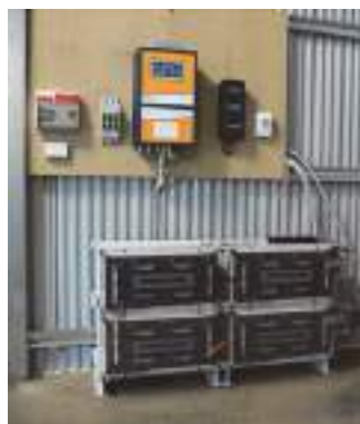
Նկ. 6.6.8. Մեկ վահանակի վրա ինվերտորի, լիցքավորման կարգավորիչի և էլեկտրական անջատիչների մոնտաժի օրինակ
