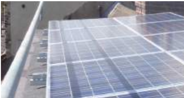
Նկ. 7.3.2. Սխալ մոնտաժի հետևանքով, արևային ֆոտովոլտային մոդուլների ստվերումը խողովակների կողմից (ձախ նկար) և ջրատար ռետինե խողովակի կողմից (աջ նկար)
