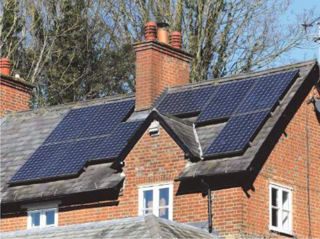
Նկ. 3.5.1. Տանիքի մեջ տեղադրված հարթ արևային կոլեկտորներ
