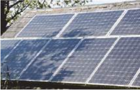
Նկ. 7.3.8. Արևային ֆոտովոլտային մոդուլների ստվերումը բուսականության և կառուցված շինության կողմից
