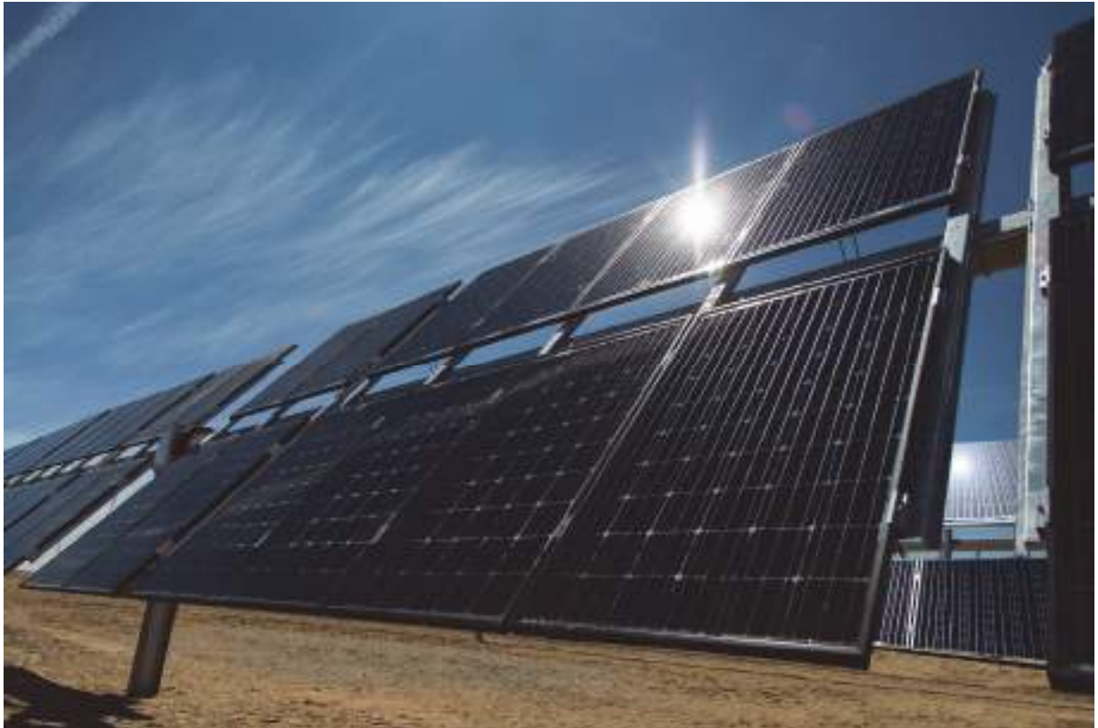
Նկ. 5.3.10. Երկկողմանի արևային մոդուլներով ֆոտովոլտային կայանք
