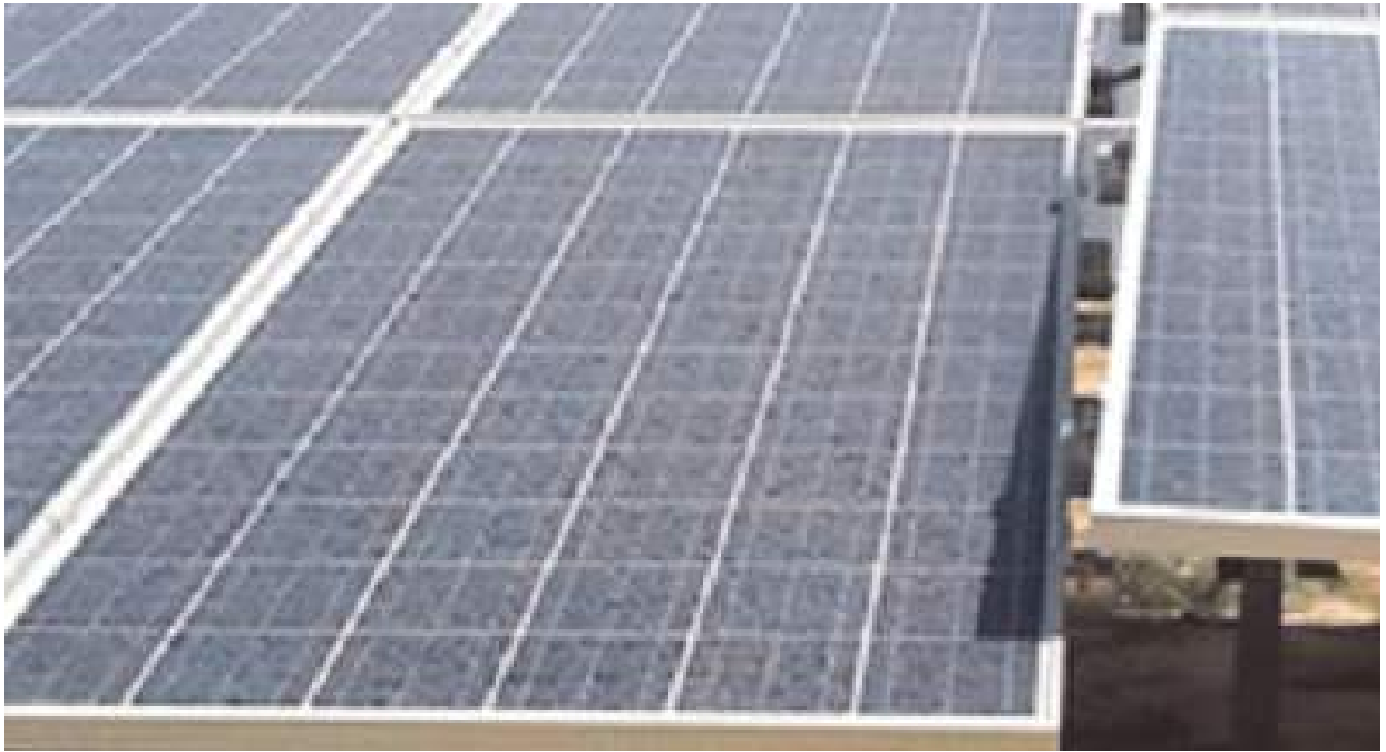
Նկ. 7.3.1. Արևային ֆոտովոլտային մոդուլների սխալ մոնտաժ
