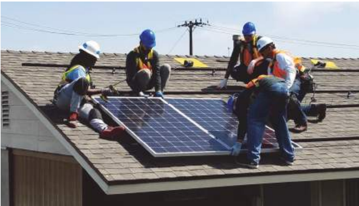
Նկ. 6.1.3. Արևային ֆոտովոլտային համակարգ մոնտաժողներ, որոնք կրում են բոլոր պահանջվող անհատական պաշտպանիչ միջոցները
