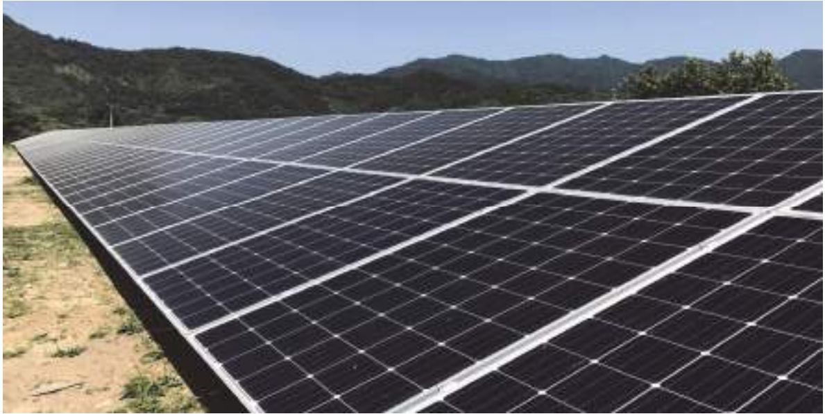
Նկ. 6.2.2. Ֆոտովոլտային մոդուլների մոնտաժ գետնի վրա
