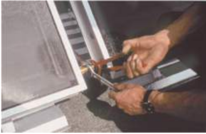
Նկ. 3.6.4. Կոլեկտորների խողովակների մոնտաժում (ձախ), օդանցքի տեղադրում (աջ)
