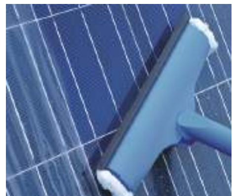
Նկ. 7.4.1. Արևային ֆոտովոլտային մոդուլների մակերեսի մաքրումը խոզանակով և ջրով
