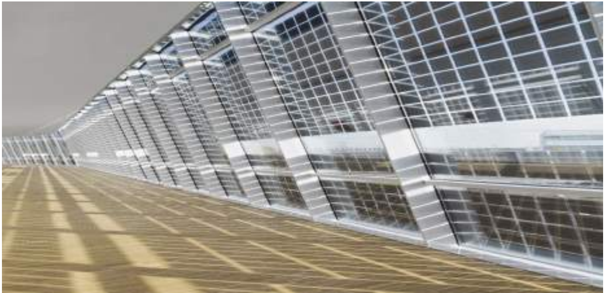
Նկ. 6.2.4. Շենքին ինտեգրված մոնտաժ: Պատուհանների փոխարեն տեղադրված են ֆոտովոլտային մոդուլներ
