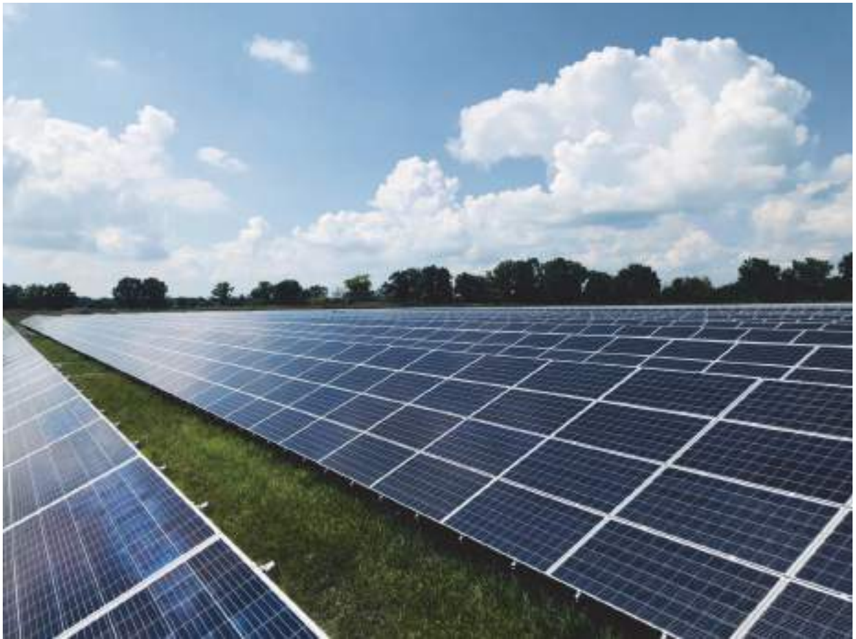
Նկ. 1.4.7. Կիսահաղորդչային ֆոտովոլտային մոդուլներից կազմված Արևային էլեկտրակայան
