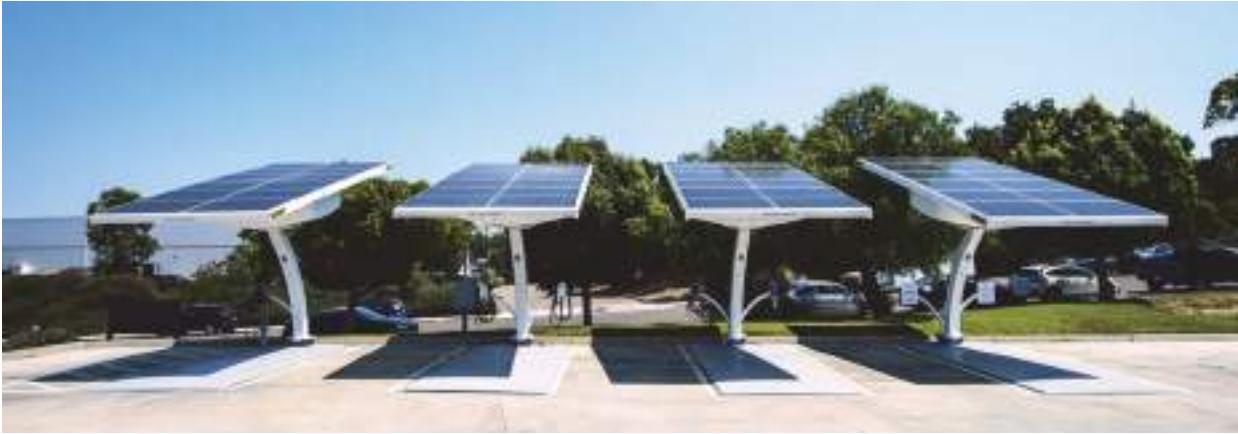
Նկ. 6.2.3. Ֆոտովոլտային մոդուլների մոնտաժ հենասայան վրա
