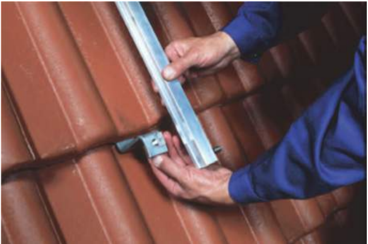
Նկ. 3.4.4. Ռելսերի ամրացումը մոնտաժային բարձակներին
