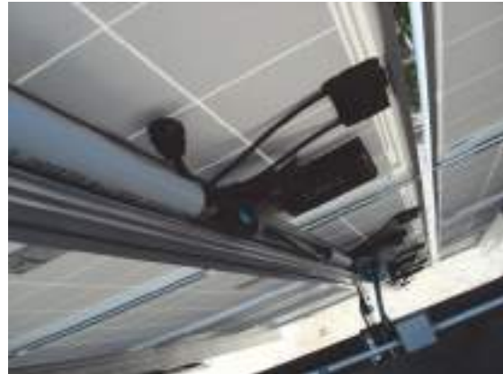
Նկ. 7.3.4. Մալուխների ճիշտ կատարված մոնտաժի օրինակներ
