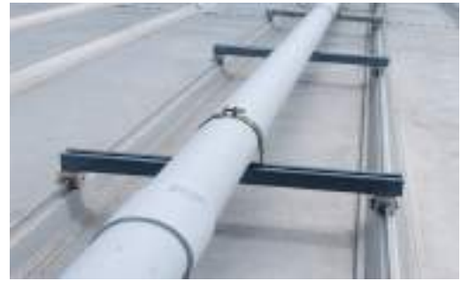
Նկ. 6.6.7. Կղմինդրե և հարթ տանիքների վրա խողովակների մոնտաժի օրինակներ
