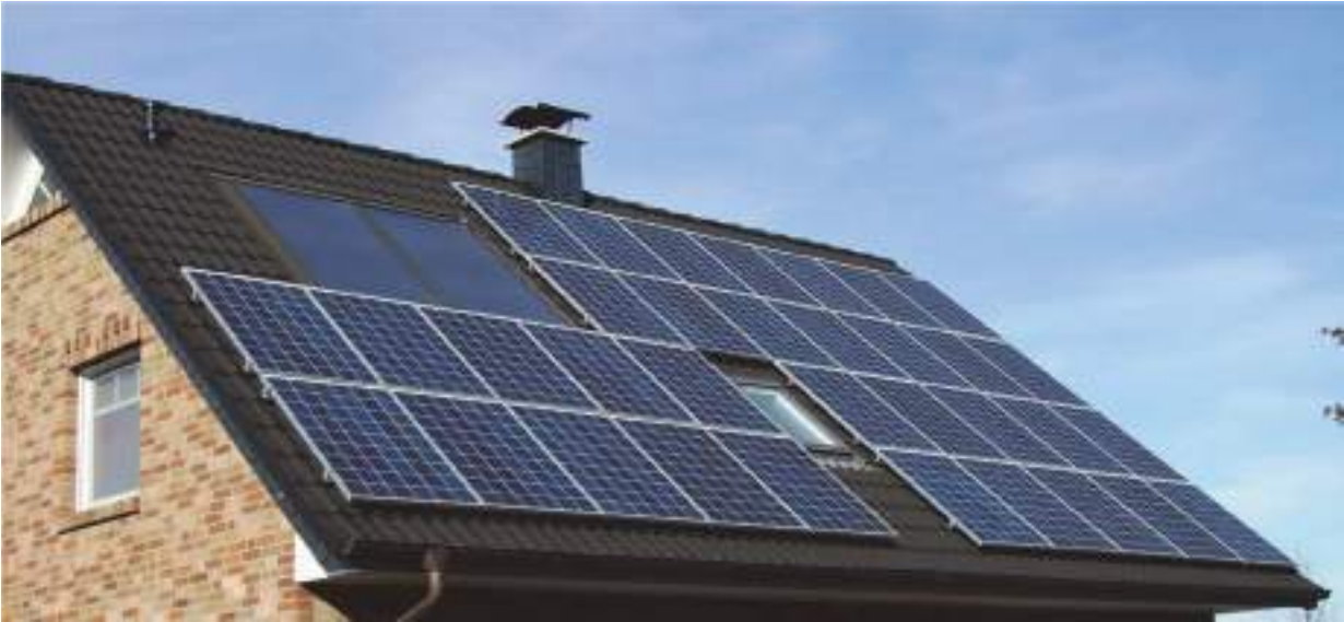
Նկ. 6.2.1. Ֆոտովոլտային մոդուլների համահավասար մոնտաժ թեք տանիքի վրա
