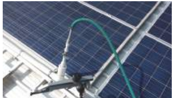
Նկ. 7.3.2. Սխալ մոնտաժի հետևանքով, արևային ֆոտովոլտային մոդուլների ստվերումը խողովակների կողմից (ձախ նկար) և ջրատար ռետինե խողովակի կողմից (աջ նկար)
