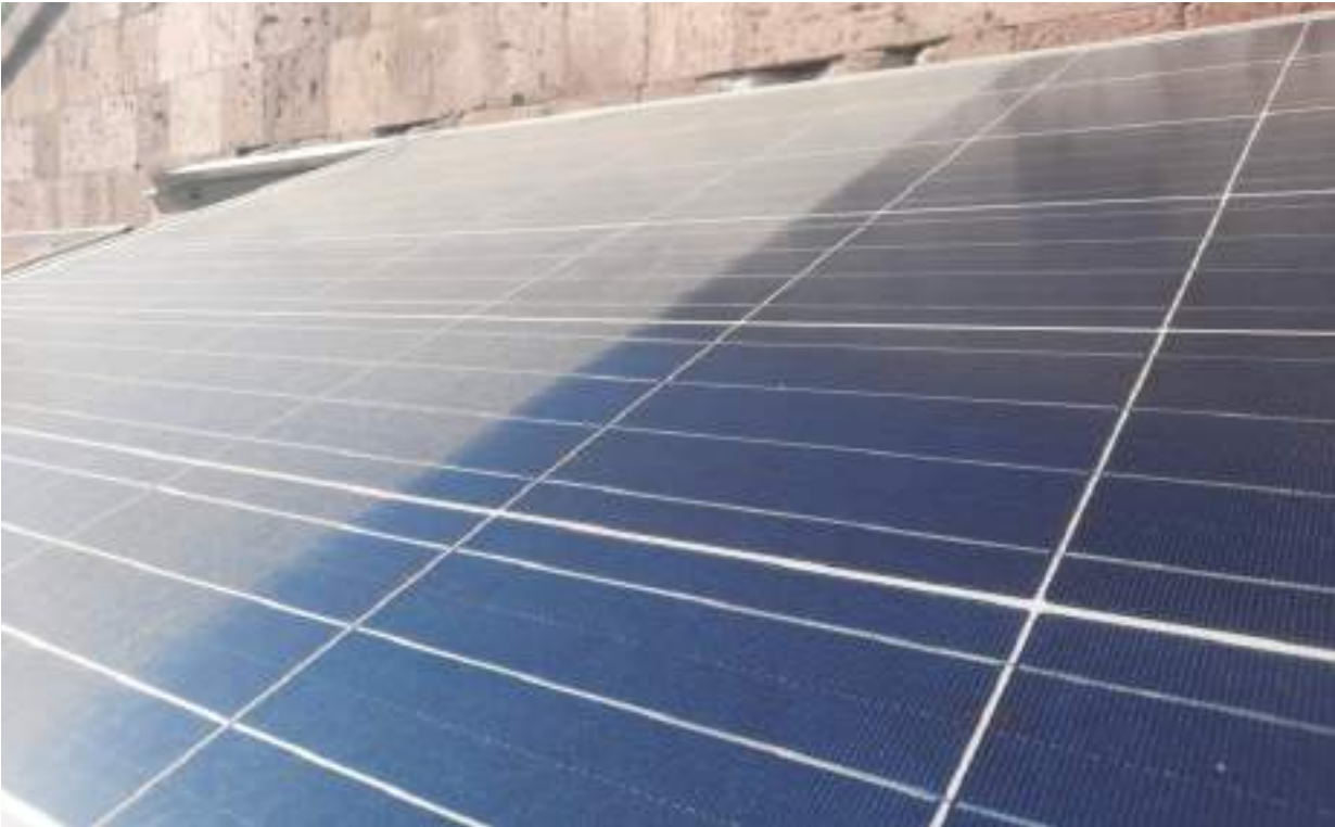
Նկ. 5.4.3. Ֆոտովոլտային մոդուլ փոշոտված և կիսով չափ մաքրված մակերեսով՝ նկարահանված ամռանը (2021 թ.), Երևանում
