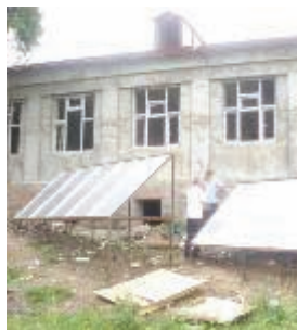
Արևային ջրատաքացուցիչներով համակարգի կառուցումը՝ զուգահեռ վերակառուցման աշխատանքների (26.07.2010)
